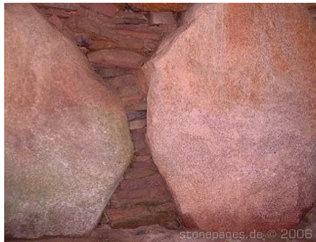
Zwischenräume wurden mit mörtellosem Mauerwerk verschlossen
