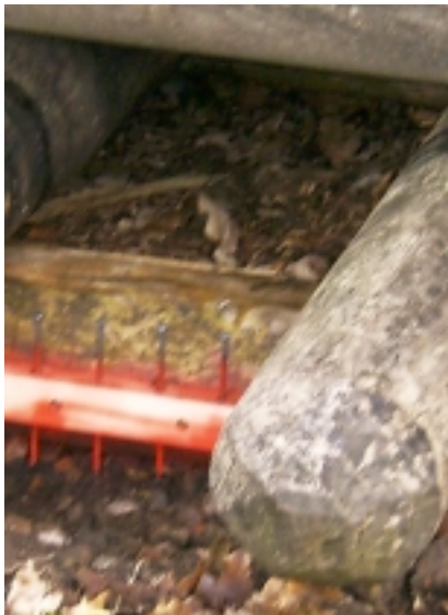
Abbildung Nr. 7 c) Die Rollhölzer drücken die Nägel um die Quetschstrecke ein.
